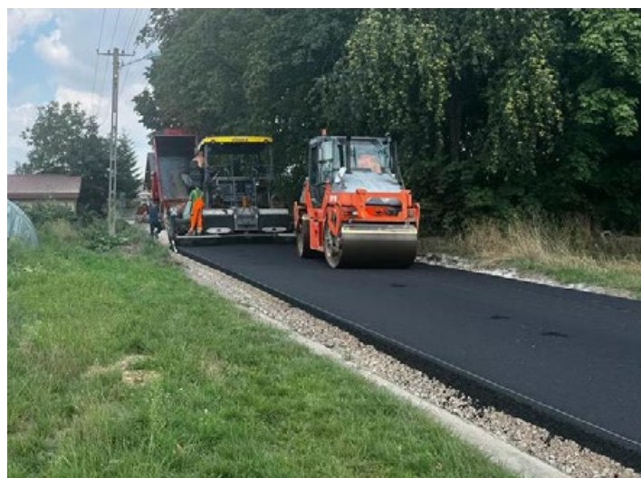
Przebudowa drogi w Leosinie na finiszu
