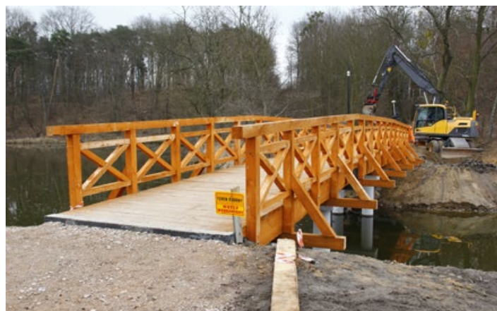
Budowa mostku łączącego dwa brzegi zalewu
