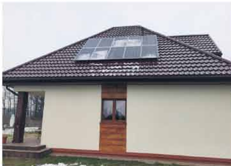
Panele fotowoltaiczne były montowane przede wszystkim na dachach domów.
