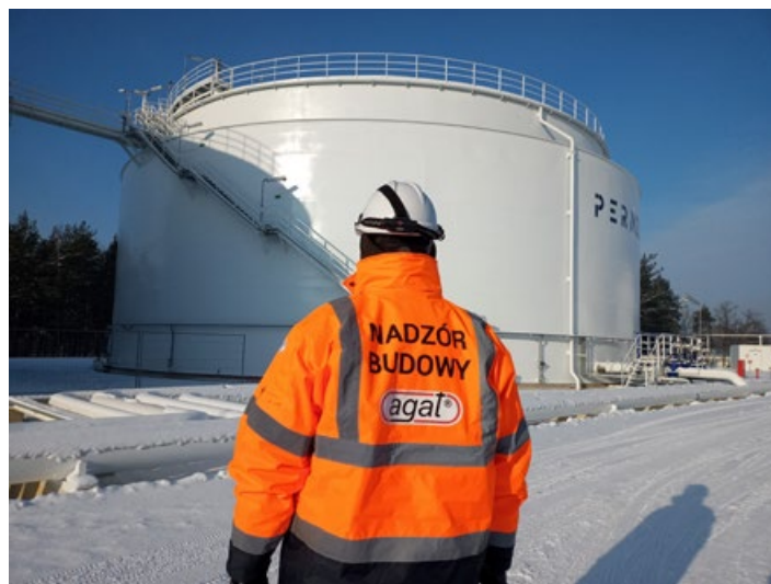
Budowa zbiorników magazynowych w Bazie Paliw w Emilianowie
