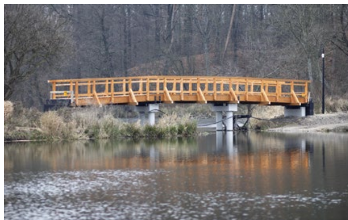
Drewniany most połączył brzegi zalewu w Lisowicach.
