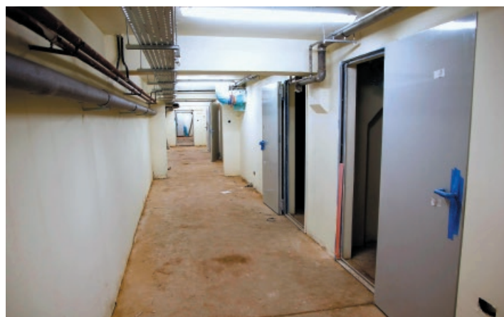
Piwnica, pomieszczenia pod archiwum urzędowe
